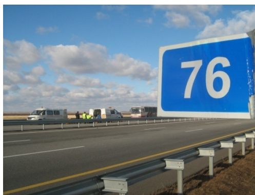
Рисунок 8. Общий вид участка (км 76+030) автомобильной дороги «Астана-Бурабай»
