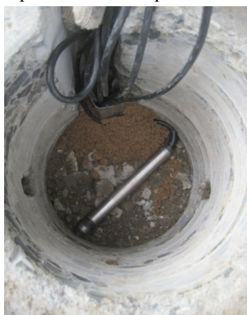
Рисунок 10. Закладка датчика в дорожную конструкцию
