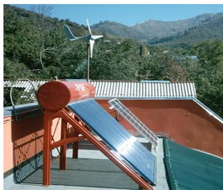
Рисунок 4 - Солнечные вакуумный водонагреватель, фотопреобразователи и ветрогенератор.
