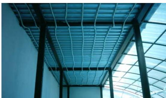
Рисунок 5 - Потолочный теплообменник рекуперации тепла.
