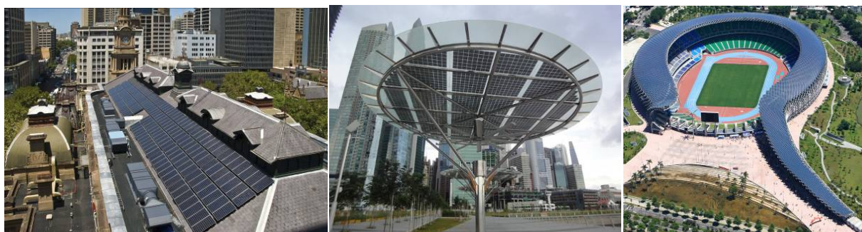
Илл. 3а. Фотовольтажные панели на здании в Сиднее. Фото 3б. Солнечная свободстоящая фотовольтажная (PV) система в городском амьбiente. Фото 3в. Инсталляция солнечных панелей на Каохсинг Национальном стадионе на Тайване http://www.publicworks.nsw.gov.au/projects/featured-projects/sydney-town-hall-photovoltaic-system http://www.wpgsystem.com/pvmonitoring.php http://completesolar.com/5-craziest-solar-panel-installations-youve-ever-seen
